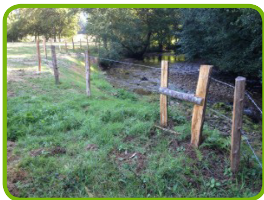
Pose de clôture afin d'éviter le piétinement du bétail
