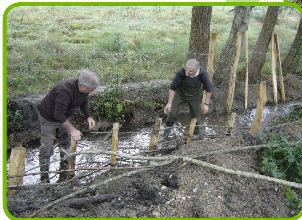
Ci-dessus : Traitement d'embâcles à Aste-Béon suite à la crue du 18 Juin 2013
