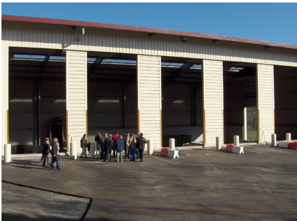
(Quai de déchargement)
