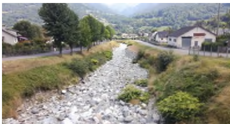
Traversé urbaine Laruns
