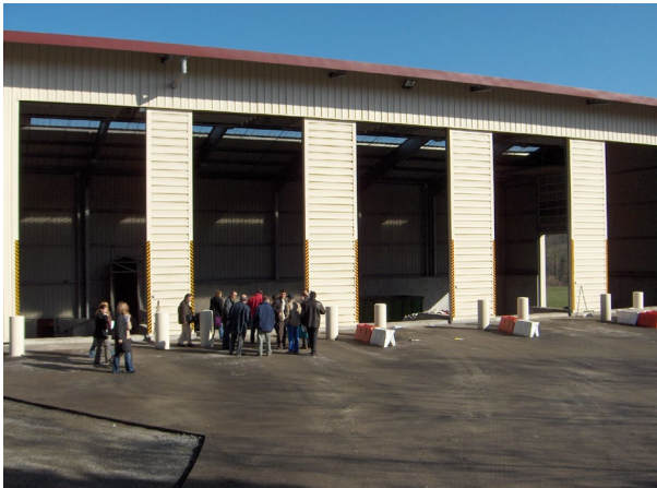
(Quai de déchargement)
