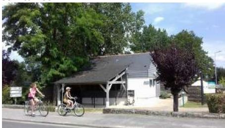
Aire d'accueil avec point d'eau potable et sanitaires
