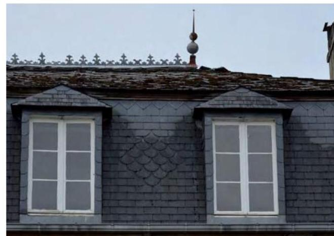
*Lucarnes en bâtière sur le brisis d'un toit à la Mansart. Décor d'ardoises taillées en écailles de poissons dans un losange entre les deux lucarnes et épi de faîtage et faitière en zinc découpé, Lasseube.*
