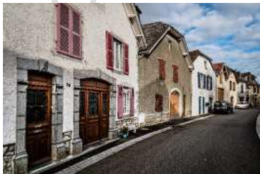
Habitat ancien dans le centre d'Arudy
