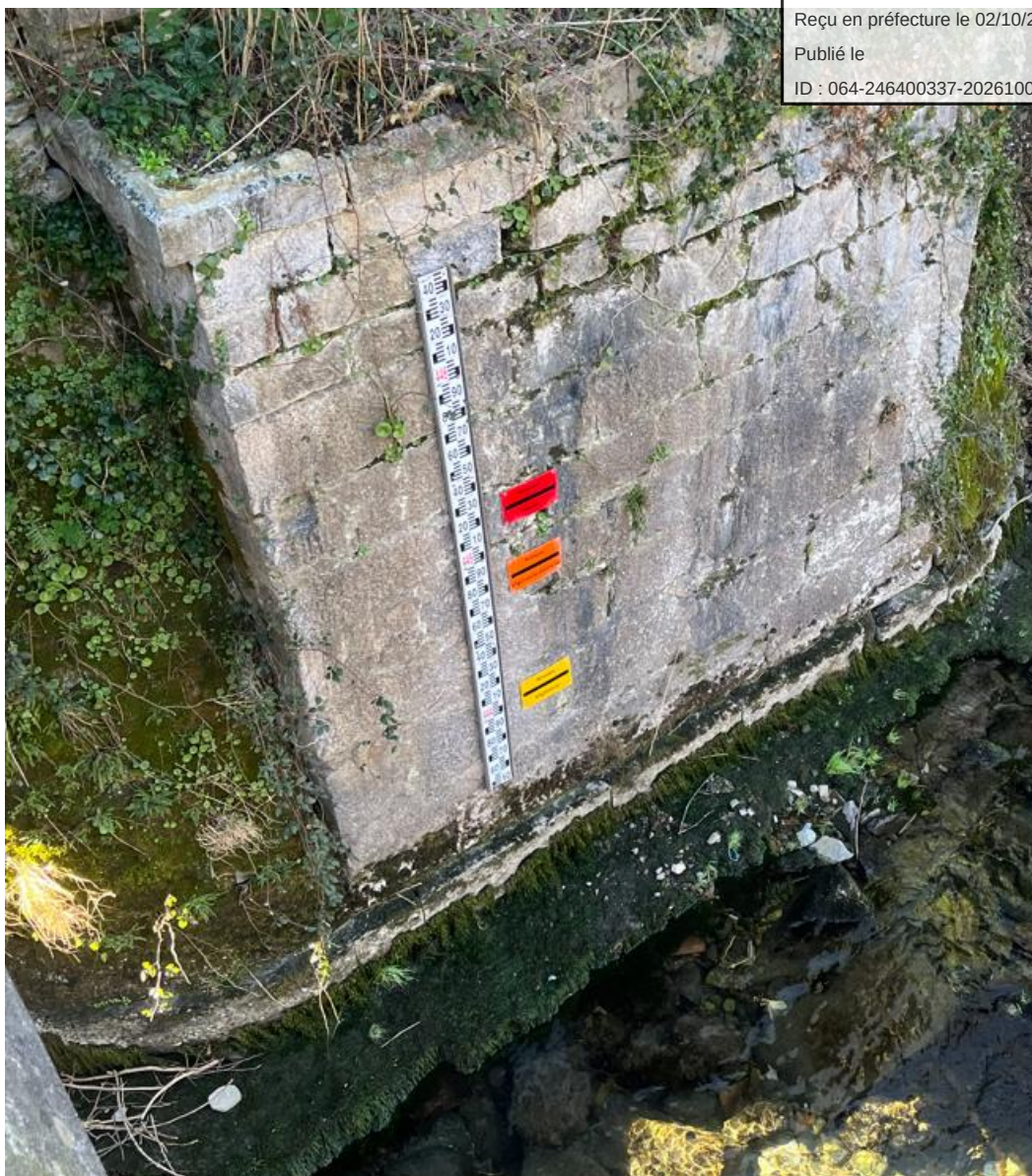
Figure 3 : Exemple de l'échelle limnimétrique positionnée sur la culée aval rive gauche du pont de Béon
