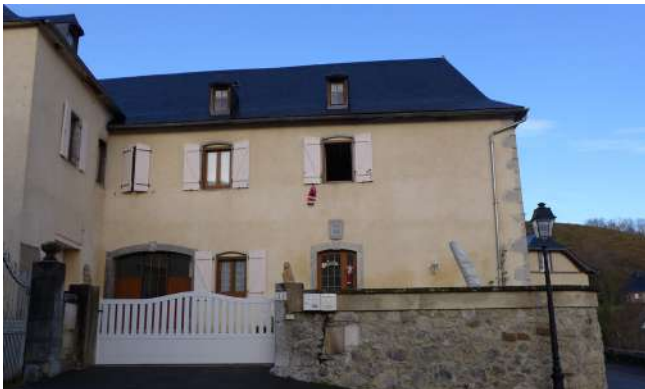
Sainte Colome, rue principale
